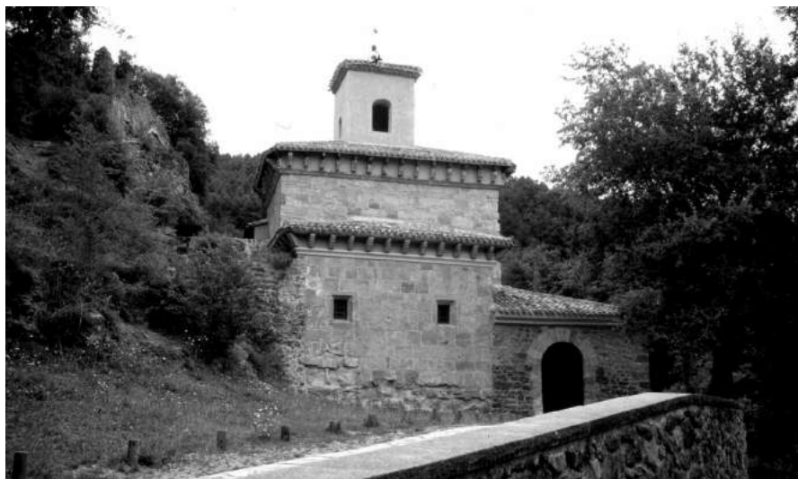
Vista de la Parroquia de Villavelayo
